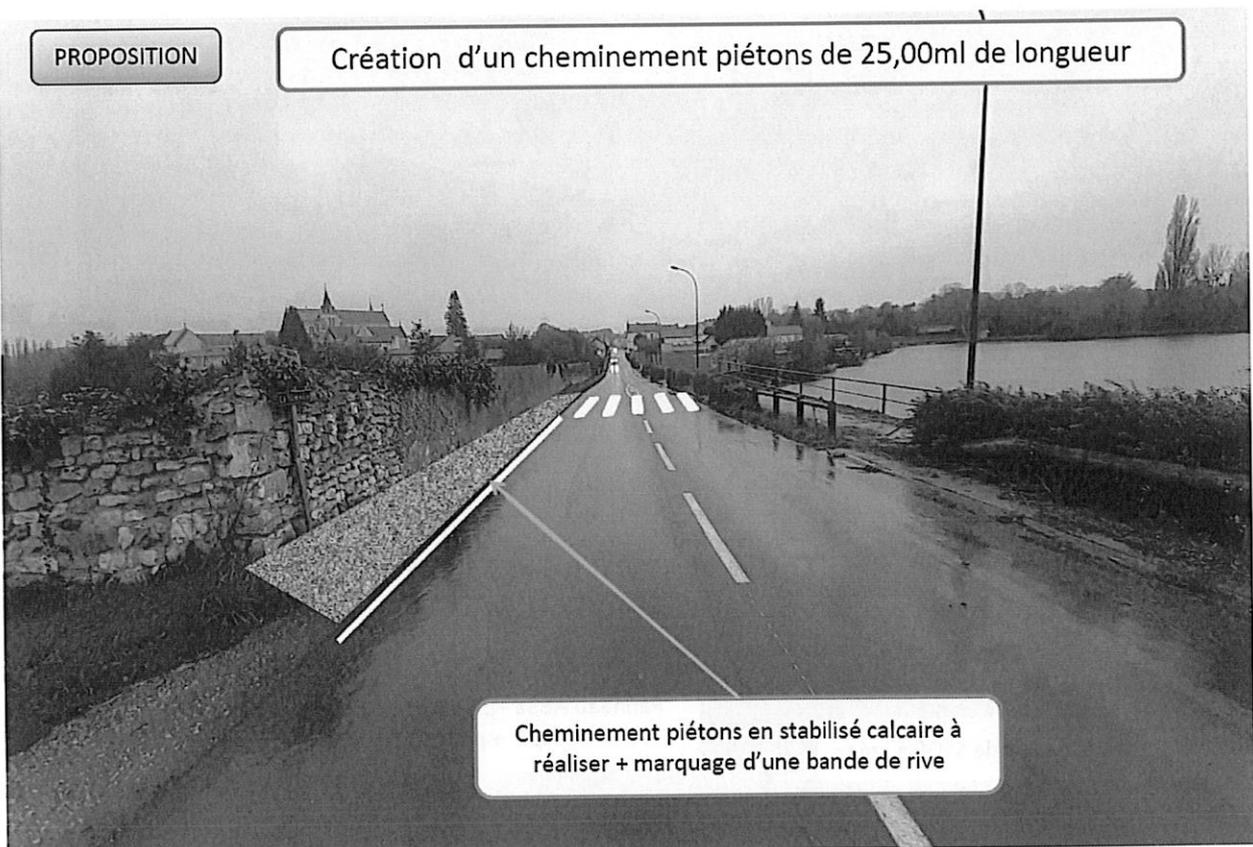
Cheminement piétons en stabilisé calcaire à réaliser + marquage d'une bande de rive
